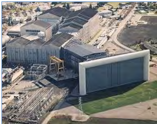
附图137：一处大型风洞设施，其建设初衷是为了循环通过后面的建筑物。后来增建了前面的进气锥道，从而能使用相同的风机进行单向风洞操作。（NASA）
