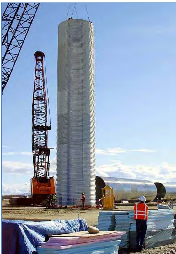
附图107: 在一个建造中的发射基地, 发射井衬套正在吊起安装到导弹发射井中。(波音公司)
