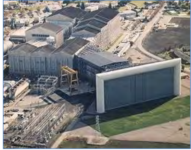
الشكل ١٣٧: منشأة نفق ريحي ضخم بني في الأصل للعمل من خلال حلقة من المباني الموجودة في الخلفية. تمت إضافة مخروط المدخل في المتمة للسماح أيضاً بالعمل مرة أخرى باستخدام نفس المراوح. (ناسا)
